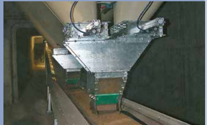
■ Phase de déchargement de silo à cellules carrées
