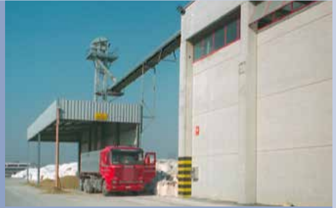
■ Déchargement en vrac de camion
